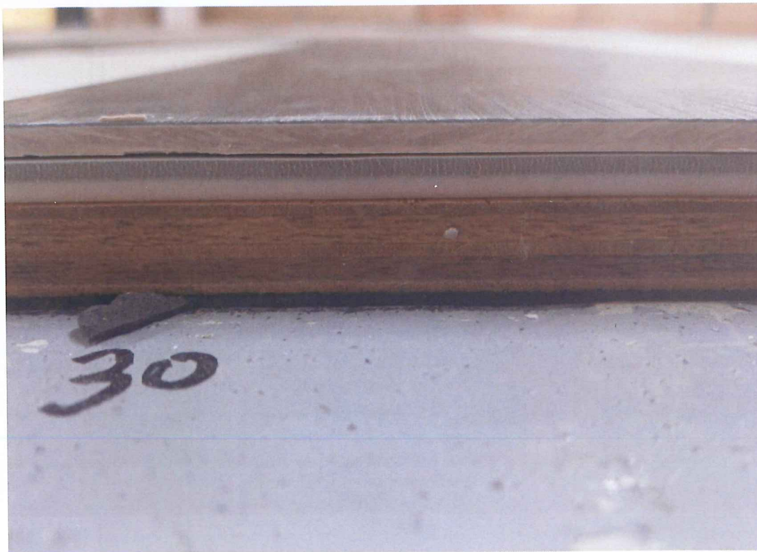
圖6.4 試件施工完成
